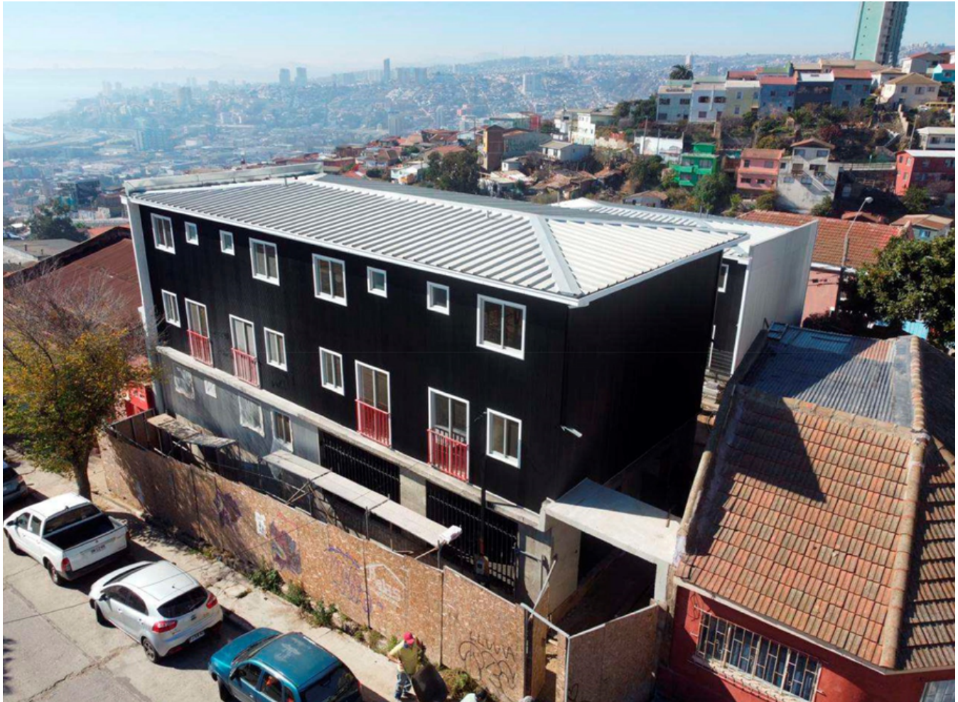
Imagen 6: Proyecto Pequeño Condominio Cerro Florida, Valparaíso. Fuente: Borde Urbano.
